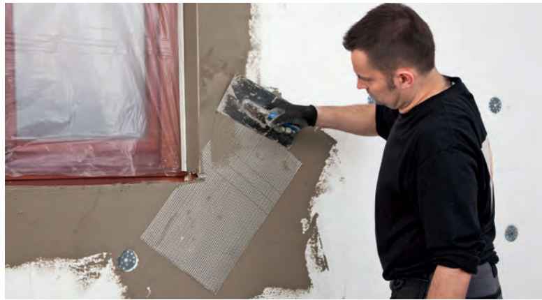
Rysunek 4.11. Wzmocnienie powierzchni ściany w narożach okien
