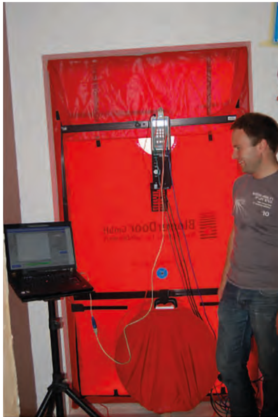
Rysunek 13.2. Test szczelności z wykorzystaniem drzwi nawiewnych
