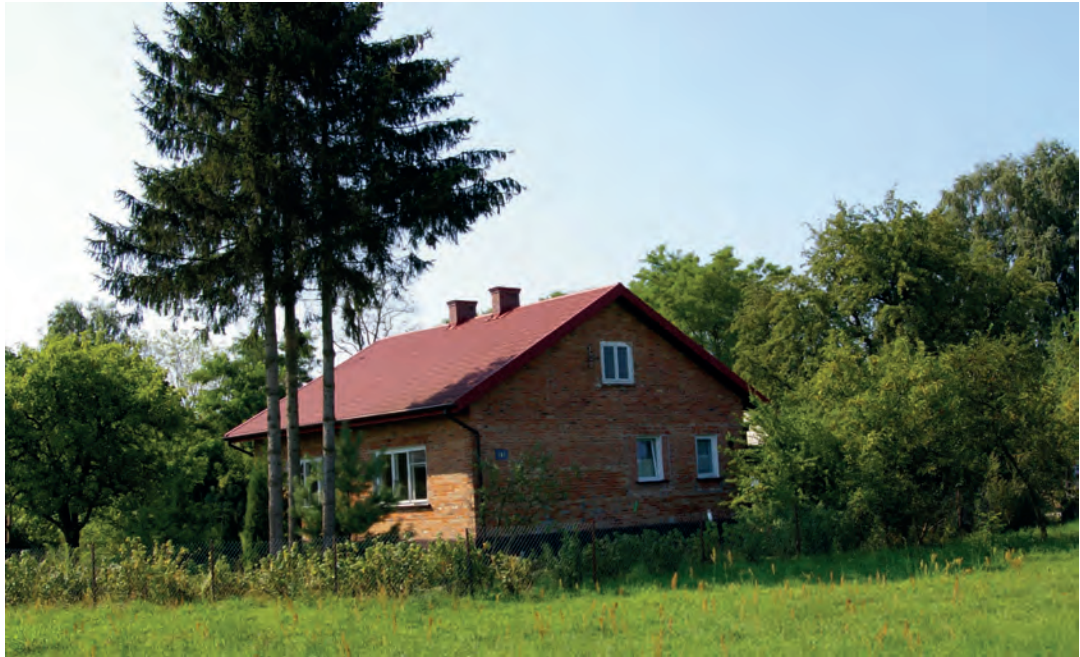
Rysunek 15.3. Dom jednorodzinny w okolicach Siedlec przewidziany do głębokiej termomodernizacji
