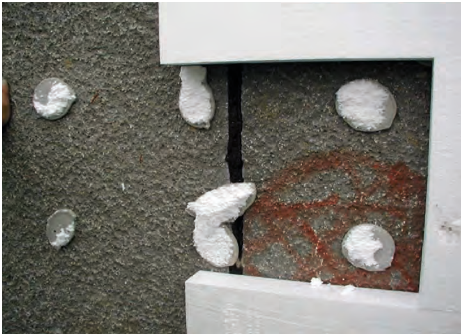
Rysunek 14.1. Brak kleju na obwodzie płyt
