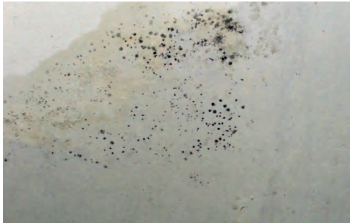
Rysunek 4.13. Rozwój grzybów na zawilgoconej powierzchni ściany
