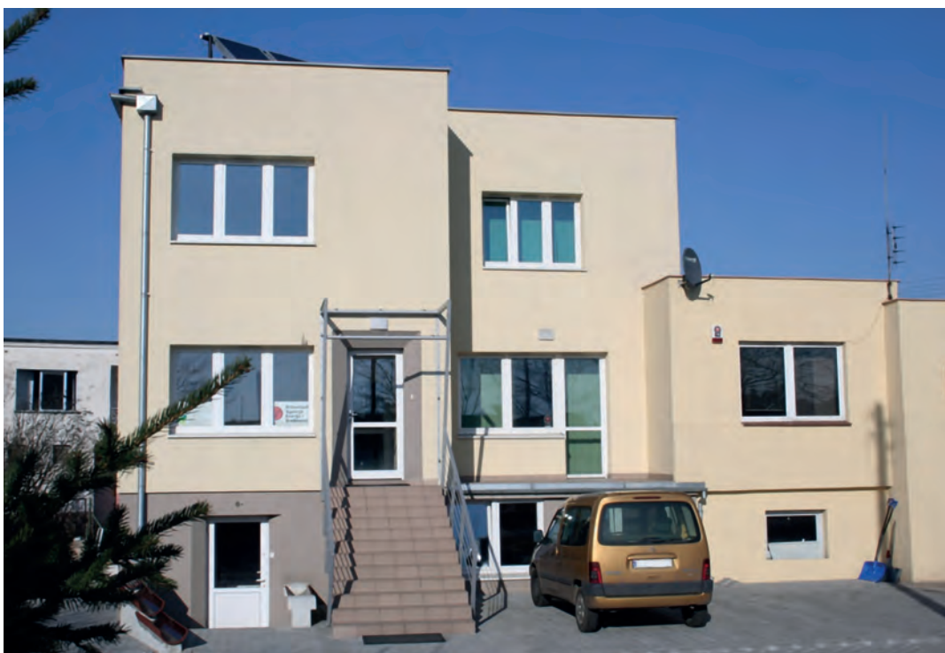
Rysunek 15.6. Dom jednorodzinny po głębokiej termomodernizacji
