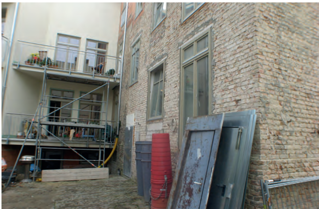
Rysunek 3.5. Wykonanie nowych balkonów zbyt blisko ściany zewnętrznej sąsiedniego budynku utrudnia jej zaizolowanie
