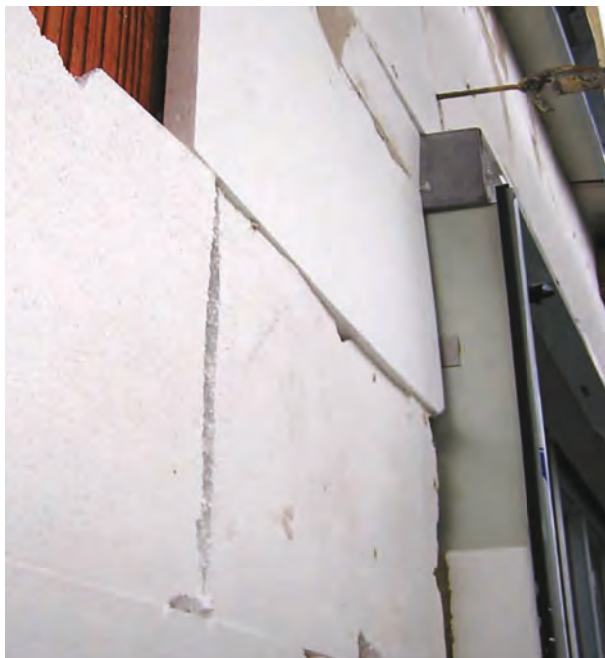
Rysunek 14.2. Niestaranne dopasowanie płyt styropianowych
