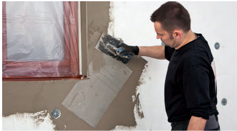
Rysunek 4.11. Wzmocnienie powierzchni ściany w narożach okien
