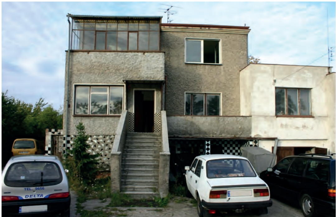
Rysunek 15.5. Dom jednorodzinny przewidziany do głębokiej termomodernizacji
