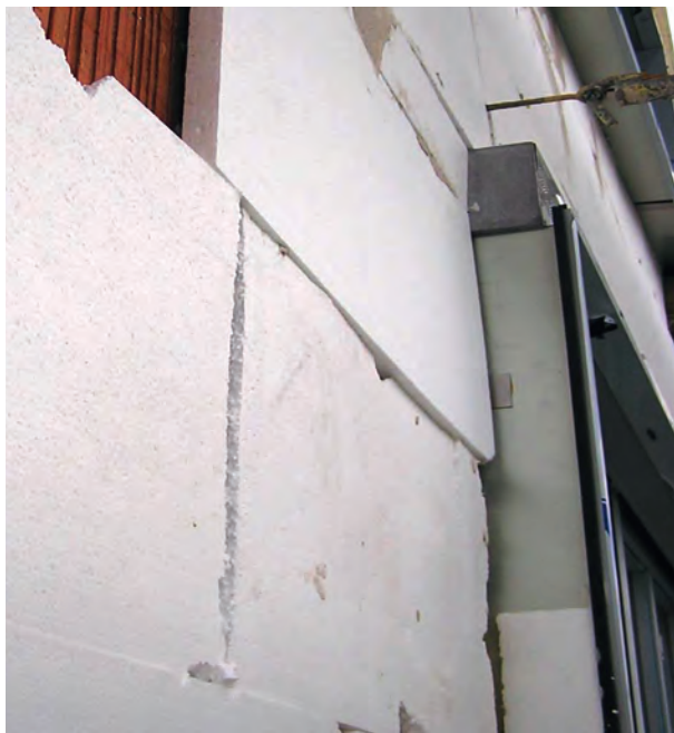
Rysunek 14.2. Niestaranne dopasowanie płyt styropianowych
