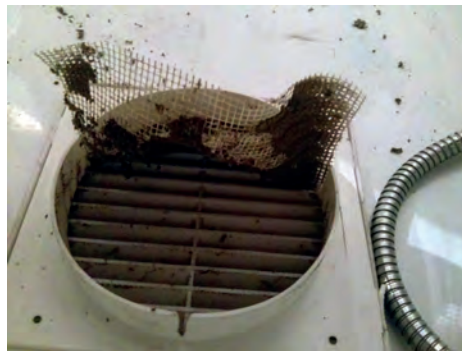
Rysunek 8.3. Zapchana kratka wentylacyjna w łazience
